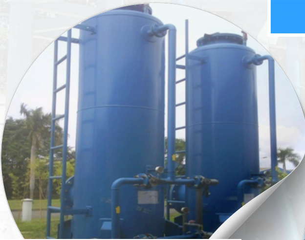
Filtration, Sand + Carbon. Surya Pamenang Kediri
